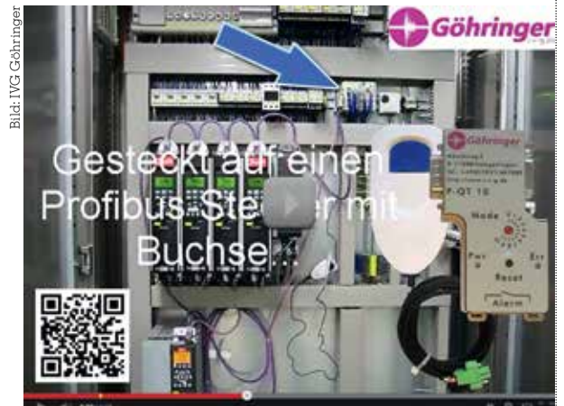
▲ Auf dem Youtube-Kanal von Hans-Ludwig Göhringer sind verschiedene Videos zur Fehlersuche mit dem Profibus-Quicktester P-QT10 mit Hupe abrufbar.
